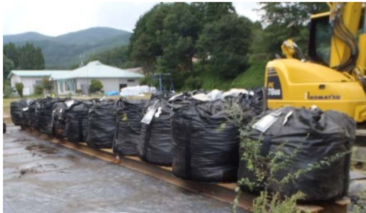
図 2.1.3-5 水切り架台の設置状況の例
